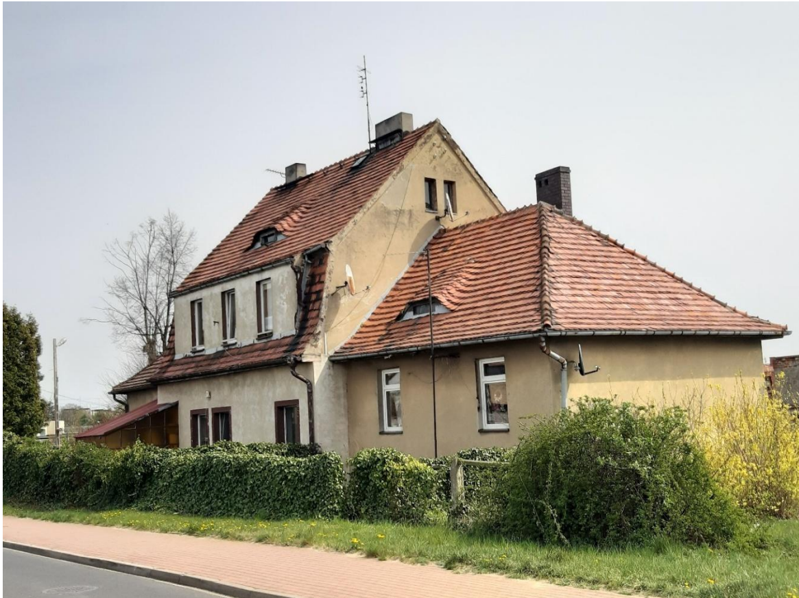
Dworzec Wieluńskiej Kolejki Wąskotorowej w Wieluniu
