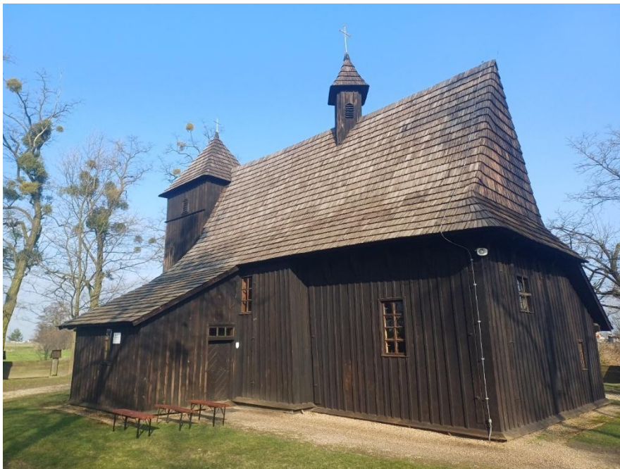
Kościół pw. Świętej Trójcy w Grębieniu, gmina Pątnów
